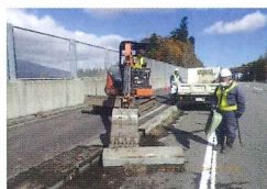
①既設材撤去
