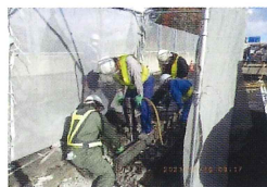
②背面(歩道)コンクリート研り
