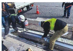
⑤流水部設置
