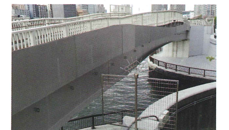
橋桁にも採用された素材です
