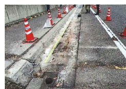
既設材撤去後の床版状況
