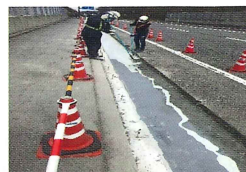
③橋面防水
