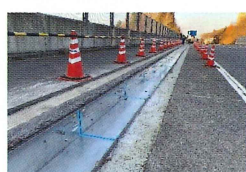
流水部設置完了
