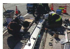
⑥流水部固定(溶接)
