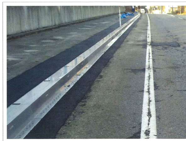
ステンレス鋼製排水溝(GブロックドレインS-plus)に更新
